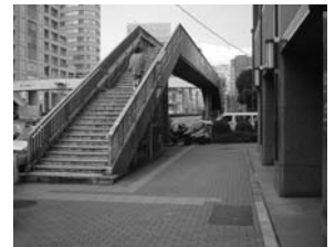
歩道橋撤去前
