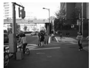
歩道橋一部撤去後
